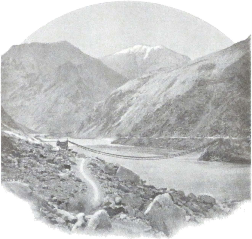
(170.) Pont de cordes sur l'Indus à Karmang.
