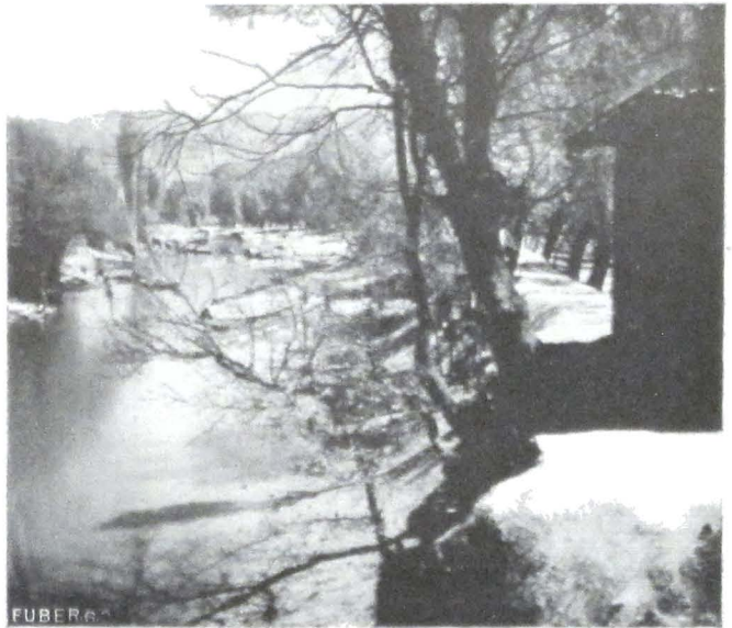
1911 Canal lateral, au Chenar Bagh.
