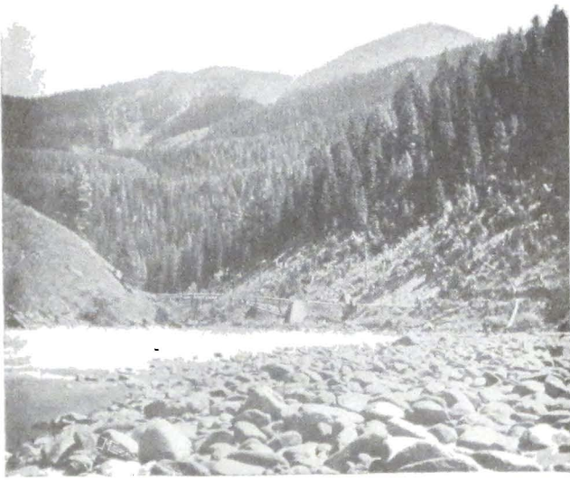
(1920.) Nouveau pont, à Kanjalwan.
